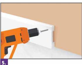
5. Si deseas utilizar clavos evita colocarlos en la ranura de atrás de los perfiles.
