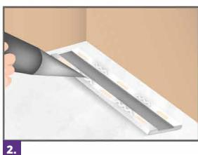
2. Aplica abundante pegamento (adhesivo PRO-FIX®, silicona neutra o cemento de contacto sin solvente) en la parte posterior del zócalo/guardapolvo/guardaescojas.
