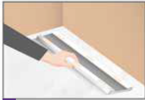
1. Adhiere cinta bifaz con cortes de 2 cm cada 40 cm y a no menos de 20 cm de los extremos del perfil.
