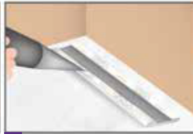
2. Aplica abundante pegamento (adhesivo PRO-FIX®, silicona neutra o cemento de contacto sin solvente) en la parte posterior del zócalo.
