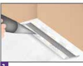
2. Aplica abundante pegamento (adhesivo PRO-FIX®, silicona neutra o cemento de contacto sin solvente) en la parte posterior del zócalo.
